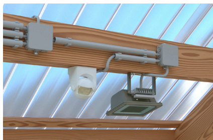
Fastgørelse af fordelingskasser, kabler og rør
