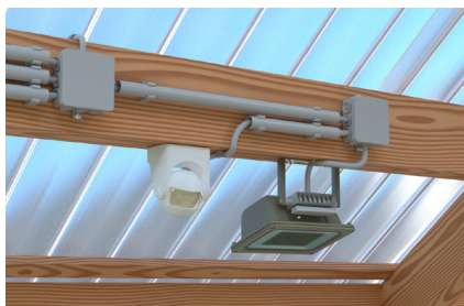
Fastgørelse af fordelingskasser, kabler og rør
